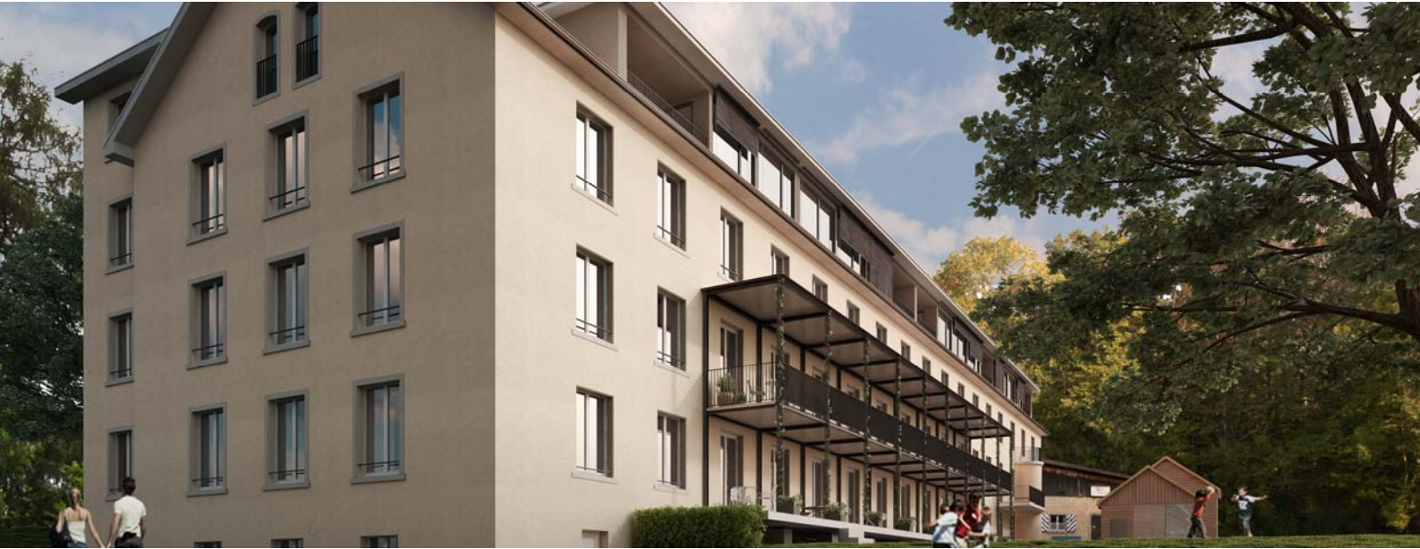
Fabrikgebäude von Südwesten
